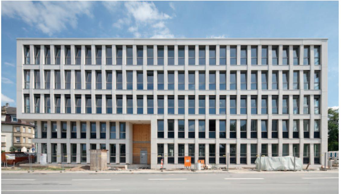
Das Bürogebäude Eastsite II in Mannheim-Neustadt führt den experimentellen Umgang in der Verwendung von Betonsandwichbauelementen weiter: Der Fassade liegt die Idee eines dreidimensionalen Flechtwerkes zugrunde. Die Betonfertigteile garantieren dabei einen hohen Präzisionsgrad und ermöglichen eine freiere Formgebung.
